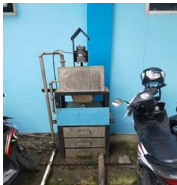
Gambar 2 Unit pengolahan limbah cair laboratorium
