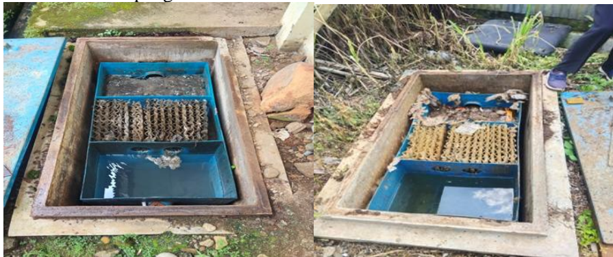
Gambar 1 Unit pengolahan limbah cair dapur dan cucian
