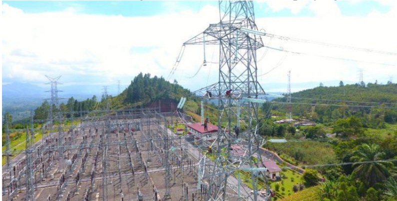
Gambar 1. SUTET 275 kV pada GITET
