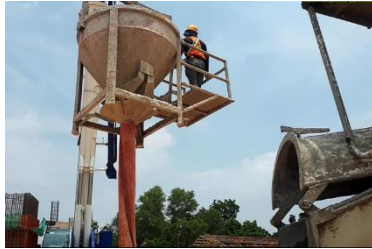
Gambar 18. Pengerjaan Pengecoran
