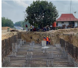
Gambar 13. Pekerjaan pembesian
