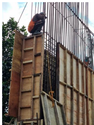
Gambar 17. Pemasangan Bekisting
