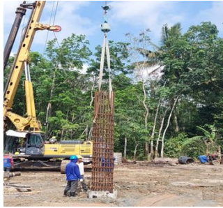
Gambar. 7 Instalasi Keranjang Besi
