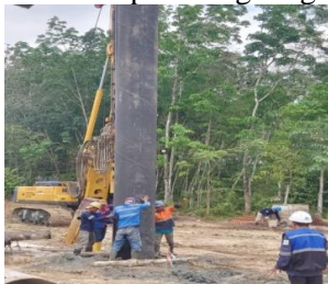
Gambar. 3 Pemasangan Casing
