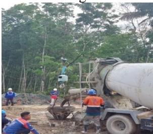
Gambar. 8 Proses Pengecoran
