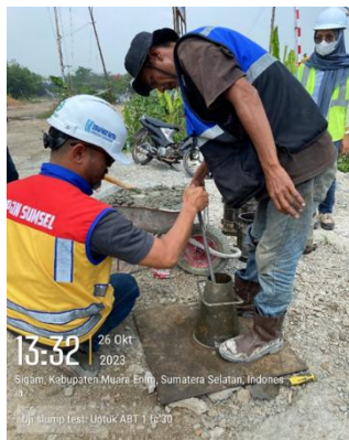
Gambar 19. Uji Slump Test
