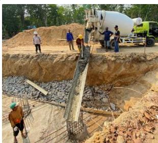
Gambar 12. Pekerjaan lantai kerja
