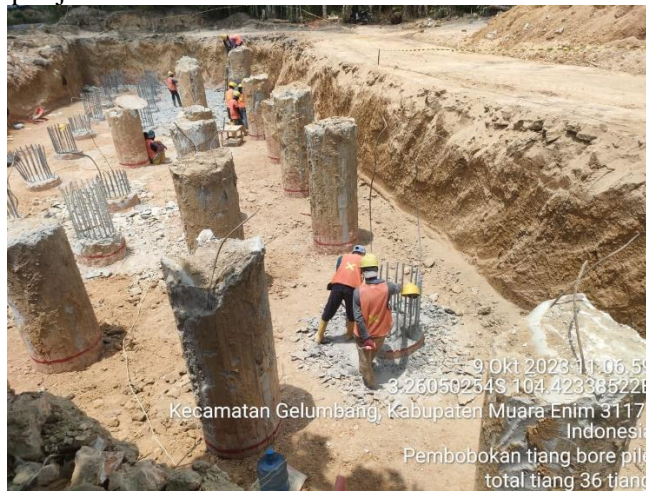
Gambar 1 Pembobokan Bore Pile
