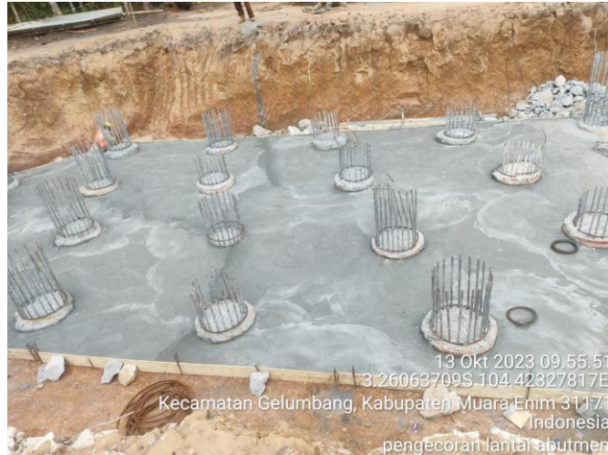
Gambar 2 Pengecoran lantai
