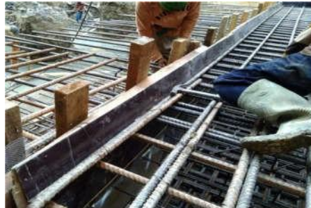
Gambar 3 Pekerjaan Bekisting
