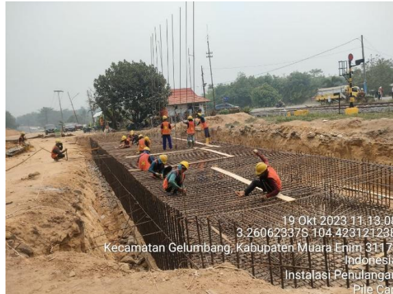
Gambar 4 Pemasangan besi
