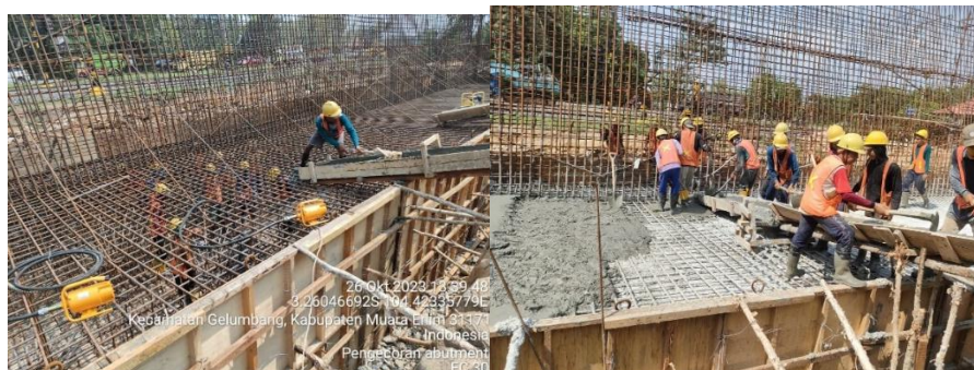
Gambar 5 Pekerjaan Pengecoran
