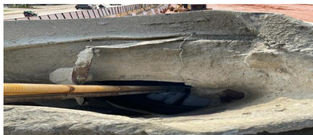
Gambar 3 Pencampuran foam pada mortar
