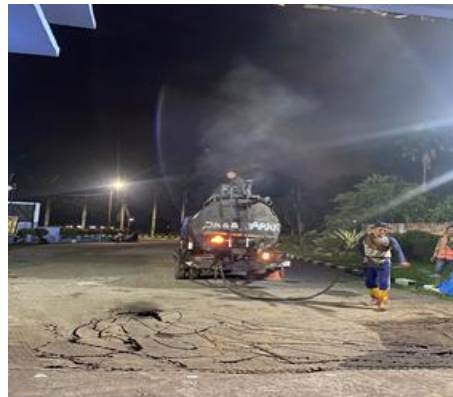
Gambar 2 Proses penyiraman aspal perekat
