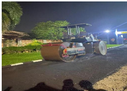
Gambar 5 Pemadatan Material AC – BC
