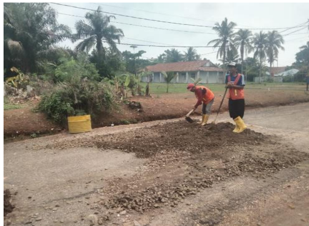
Gambar 2 penghamparan agregat kelas a
