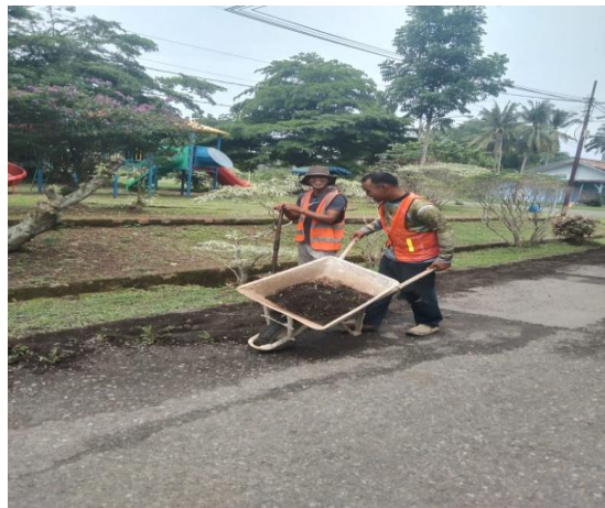
Gambar 1 pembersihan lokasi pengaspalan
