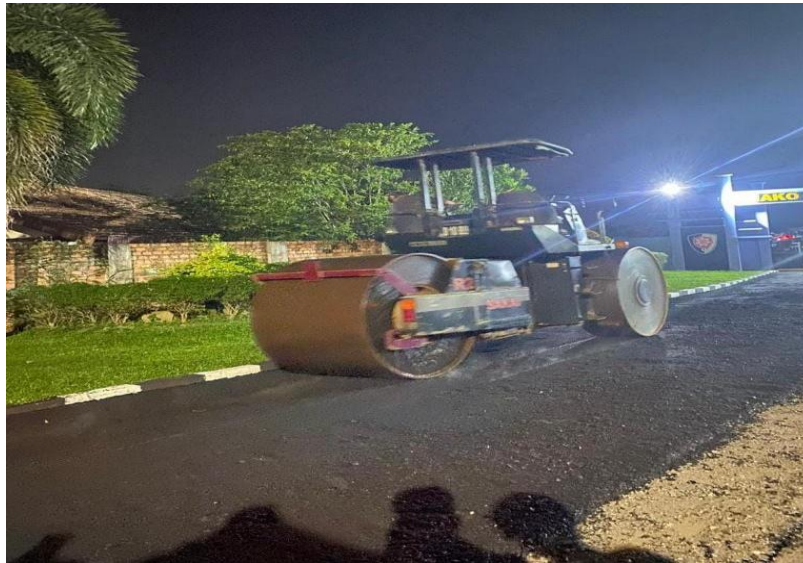
Gambar 5 Pemasangan Material AC – BC
