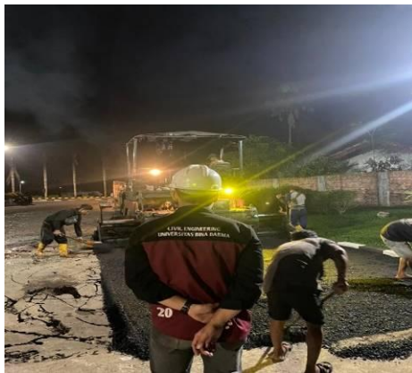
Gambar 3 penghamparan menggunakan alat finishier
