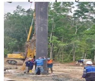
Gambar. 3 Pemasangan Casing
