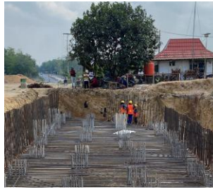
Gambar 13. Pekerjaan pembesian
