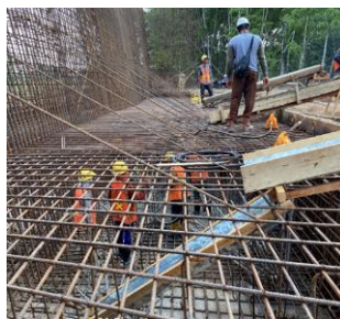
Gambar 15. Pekerjaan pengecoran
