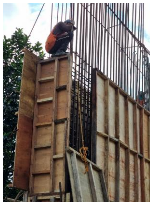
Gambar 17. Pemasangan Bekisting
