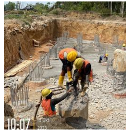
Gambar 11. Pekerjaan Pembongkaran Pembuatan lantai kerja
