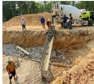
Gambar 12. Pekerjaan lantai kerja
