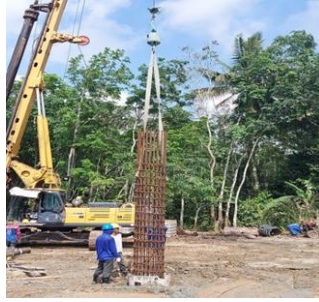
Gambar. 7 Instalasi Keranjang Besi
