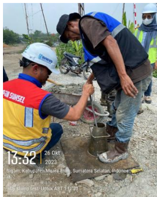
Gambar 19. Uji Slump Test
