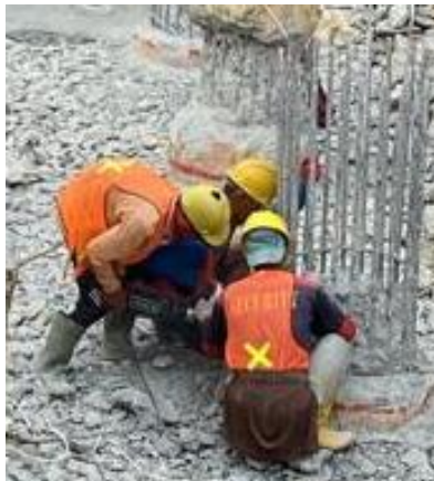
Gambar 3. Pembobokan Kepala Bored Pile
