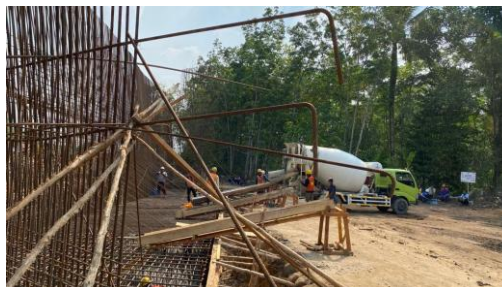
Gambar 6. Pengecoran Pile Cap
