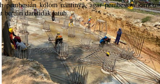
Gambar 5. Pembesian Pile Cap
