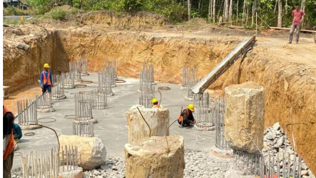
Gambar 4. Pekerjaan Lean Concrete atau Lantai kerja
