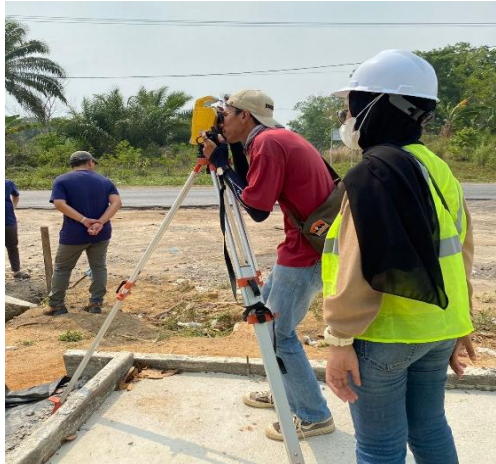
Gambar 1. Pengukuran Elevasi dan Penentuan Titik Stake Out
