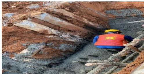
Gambar 3 Pengecoran Lantai Kerja (LC)
