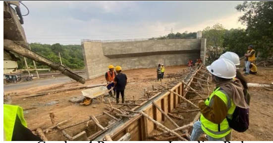
Gambar 4 Pengecoran Leveling Pad
