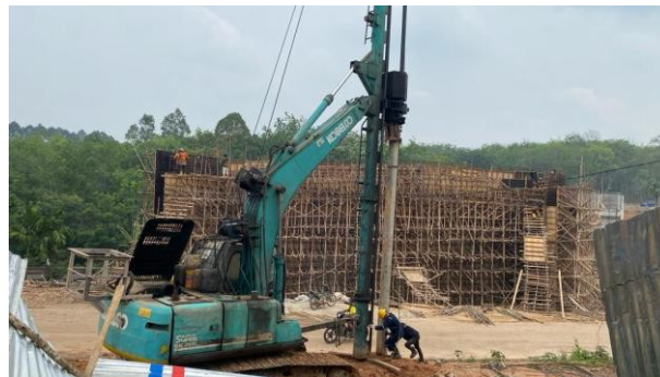
Gambar 2 Pemancangan mini pile
