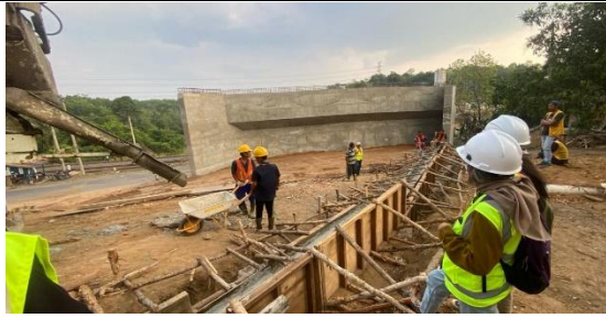
Gambar 4 Pengecoran Leveling Pad
