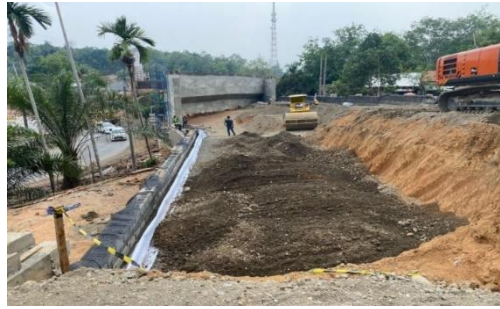
Gambar 6 penghamparan timbunan Granular
