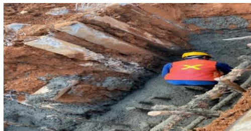
Gambar 3 Pengecoran Lantai Kerja (LC)
