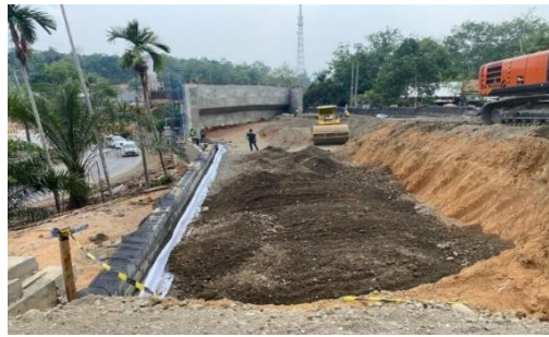
Gambar 6 penghamparan timbunan Granular
