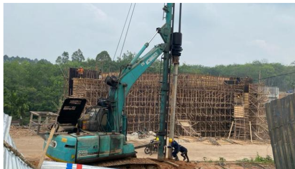
Gambar 2 Pemancangan mini pile
