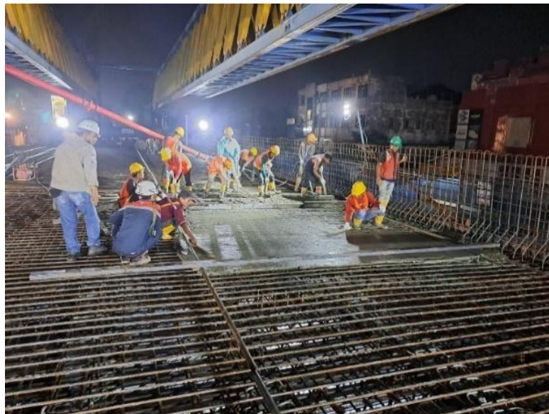
Gambar 5 Pengecoran pelat lantai
