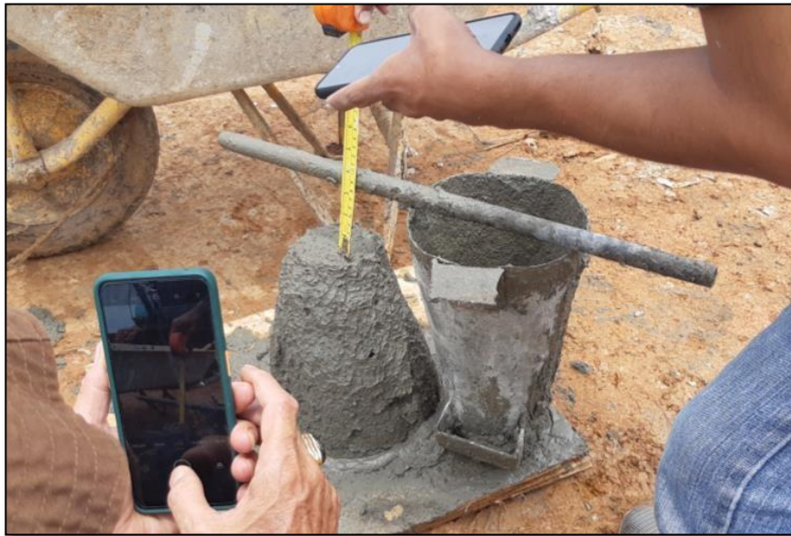
Gambar 4 Pengujian Slump Test
