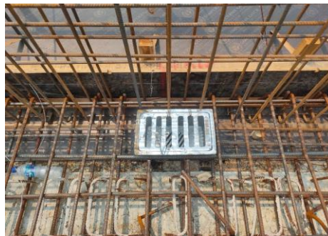
Gambar 3 pemasangan deck drain
