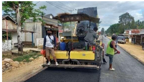
Gambar 4. Penghamparan material menggunakan Asfalt finisher
