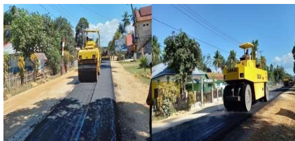
Gambar 5. Pemadatan material AC-BC
