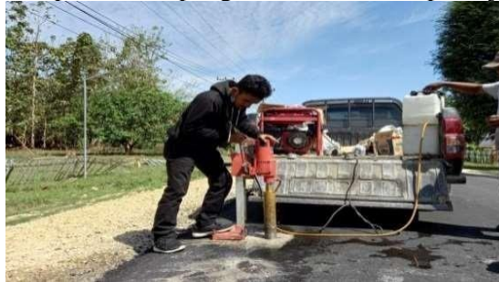
Gambar 6. Pengujian core drill AC-BC Sumber : Dokumentasi Lapangan (2023)
