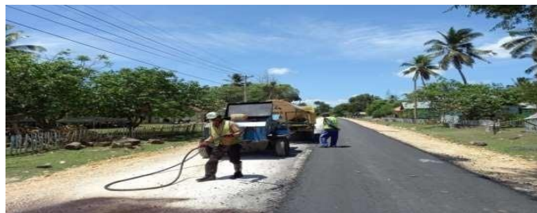
Gambar 2. Proses penyiraman Aspal perekat. Sumber : Dokumentasi Lapangan (2023)
