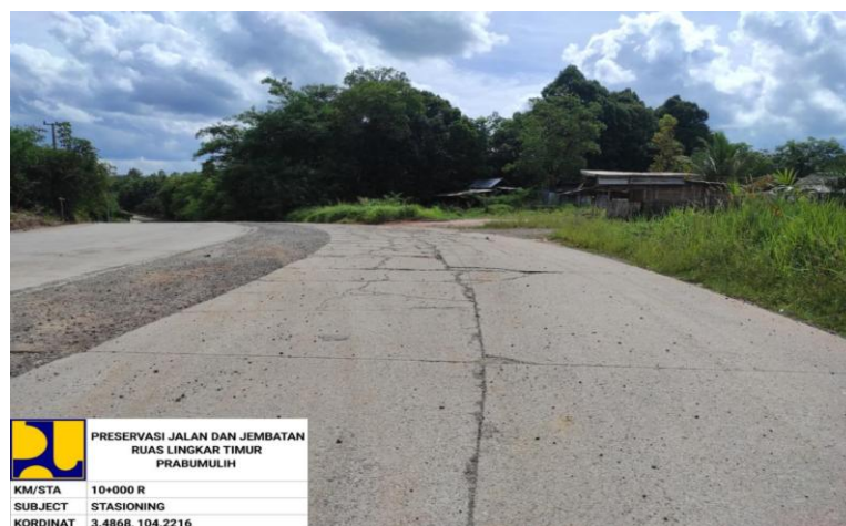
Gambar 6. Sta 09+100 s/d 10+100 jenis kerusakan jalan berlubang, amblas dan cara perbaikannya di lakukan pembongkaran aspal dan beton lama diganti dengan beton baru setebal 30 cm dibawahnya dikasih Lantai kerja setebal 10 cm.
