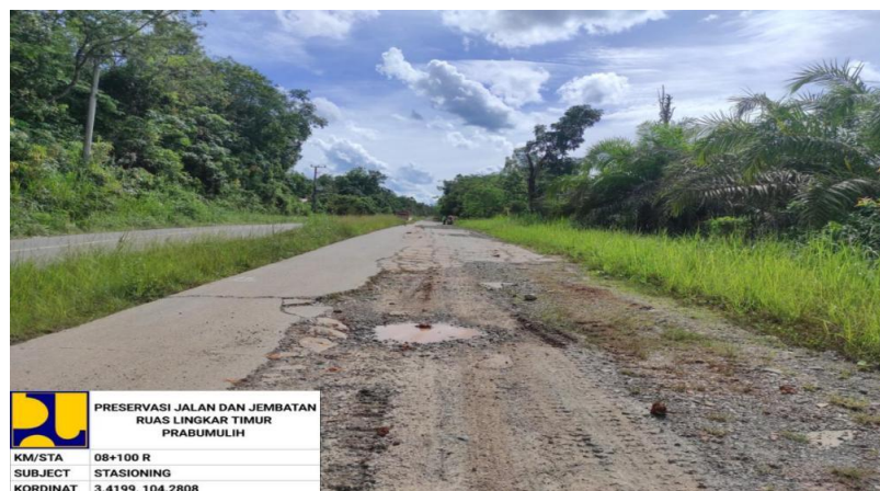
Gambar 5. Sta 08+100 s/d 09+100 jenis kerusakan jalan berlubang, amblas dan cara perbaikannya di lakukan pembongkaran aspal dan beton lama diganti dengan beton baru setebal 30 cm dibawahnya dikasih Lantai kerja setebal 10 cm.
