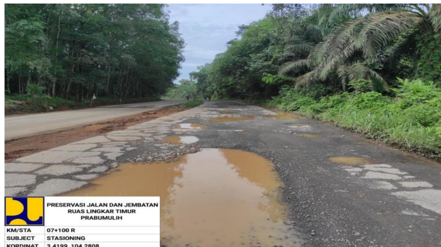
Gambar 4. Sta 07+100 s/d 08+100 jenis kerusakan jalan berlubang, amblas dan cara perbaikannya di lakukan pembongkaran aspal dan beton lama diganti dengan beton baru setebal 30 cm dibawahnya dikasih Lantai kerja setebal 10 cm.
