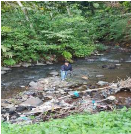
Kondisi Tumpukan Sedimen pada STA 0+200
