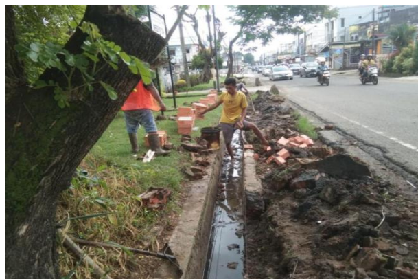
Gambar 5. Pembersihan saluran drainase
