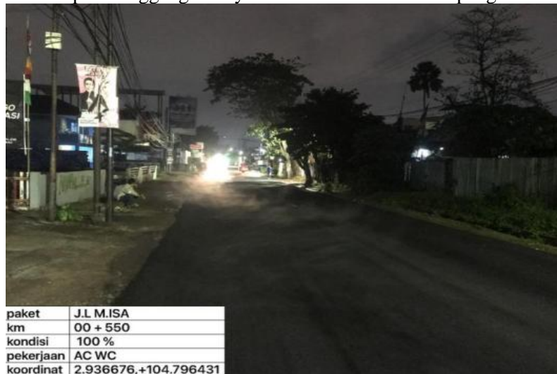
Gambar 4. Kondisi jalan yang sudah diperbaiki
