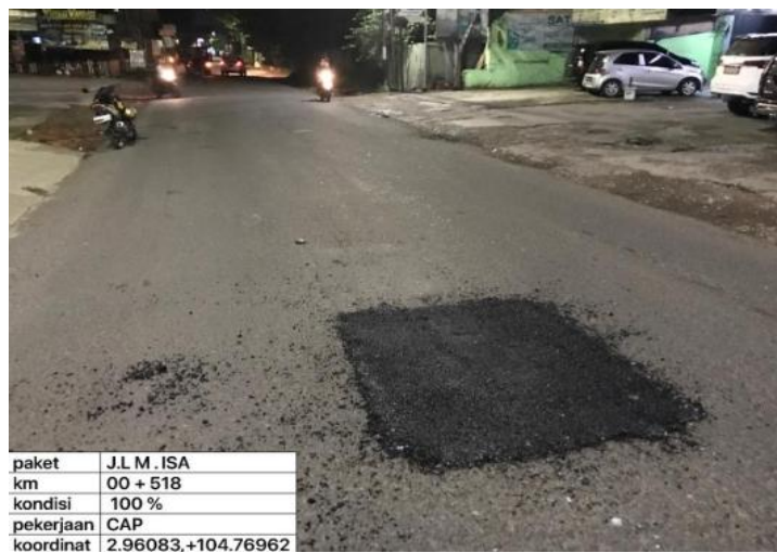
Gambar 2. Kondisi lubang setelah dilakukan perbaikan
