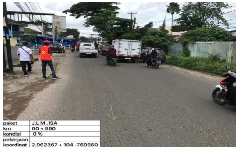
Gambar 3. Kondisi Jalan sebelum diperbaiki
