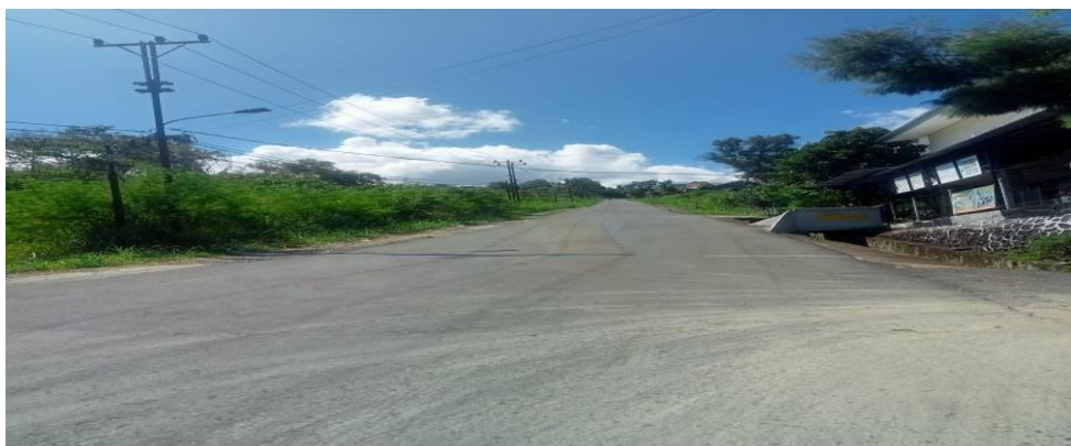
Gambar 2. Jalan yang Sudah Dicur/Beton + Aspal
